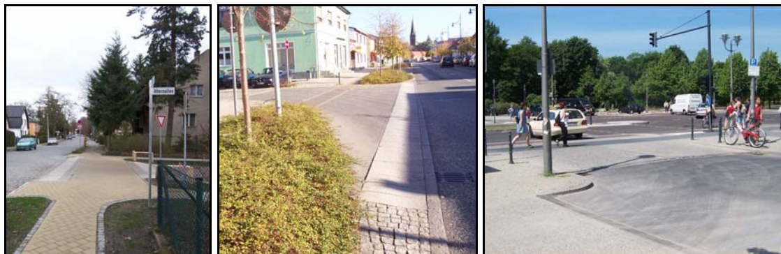
Abb. 24 Beispiele Gehwegüberfahrten bzw. -aufpflasterung (Erkner, Eberswalde, Berlin)
