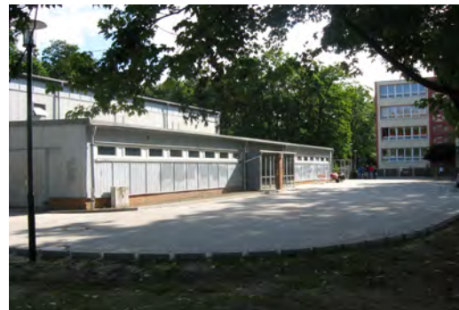
Turnhalle Oberschule J. R. Becher
