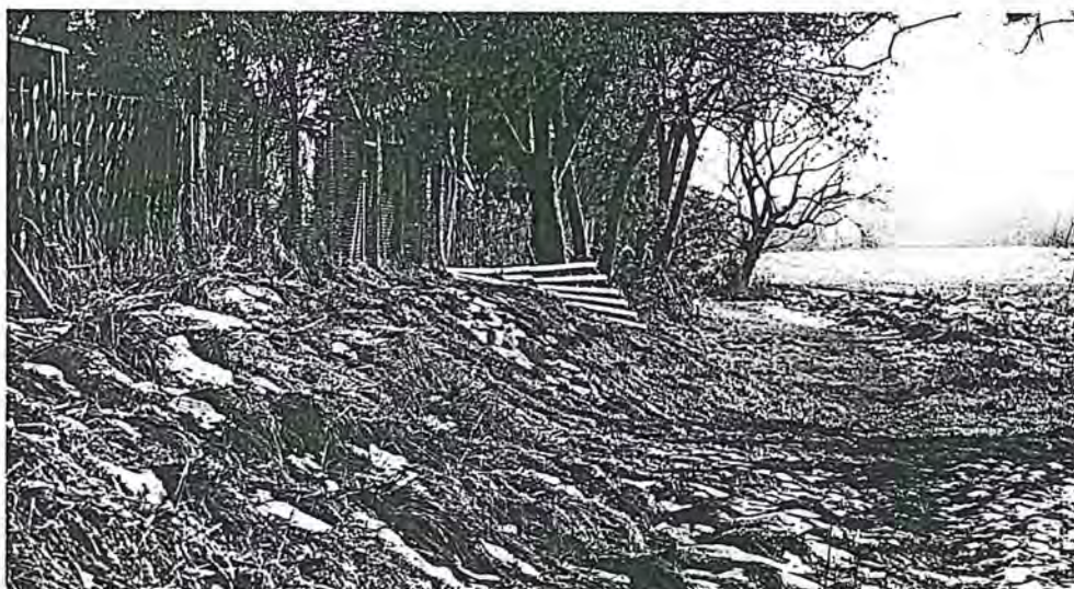
geologisch bedingte Böschungskante
