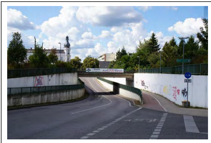
Abbildung 11: Fürstenwalder Straße, Bahnbrücke, Richtung West
