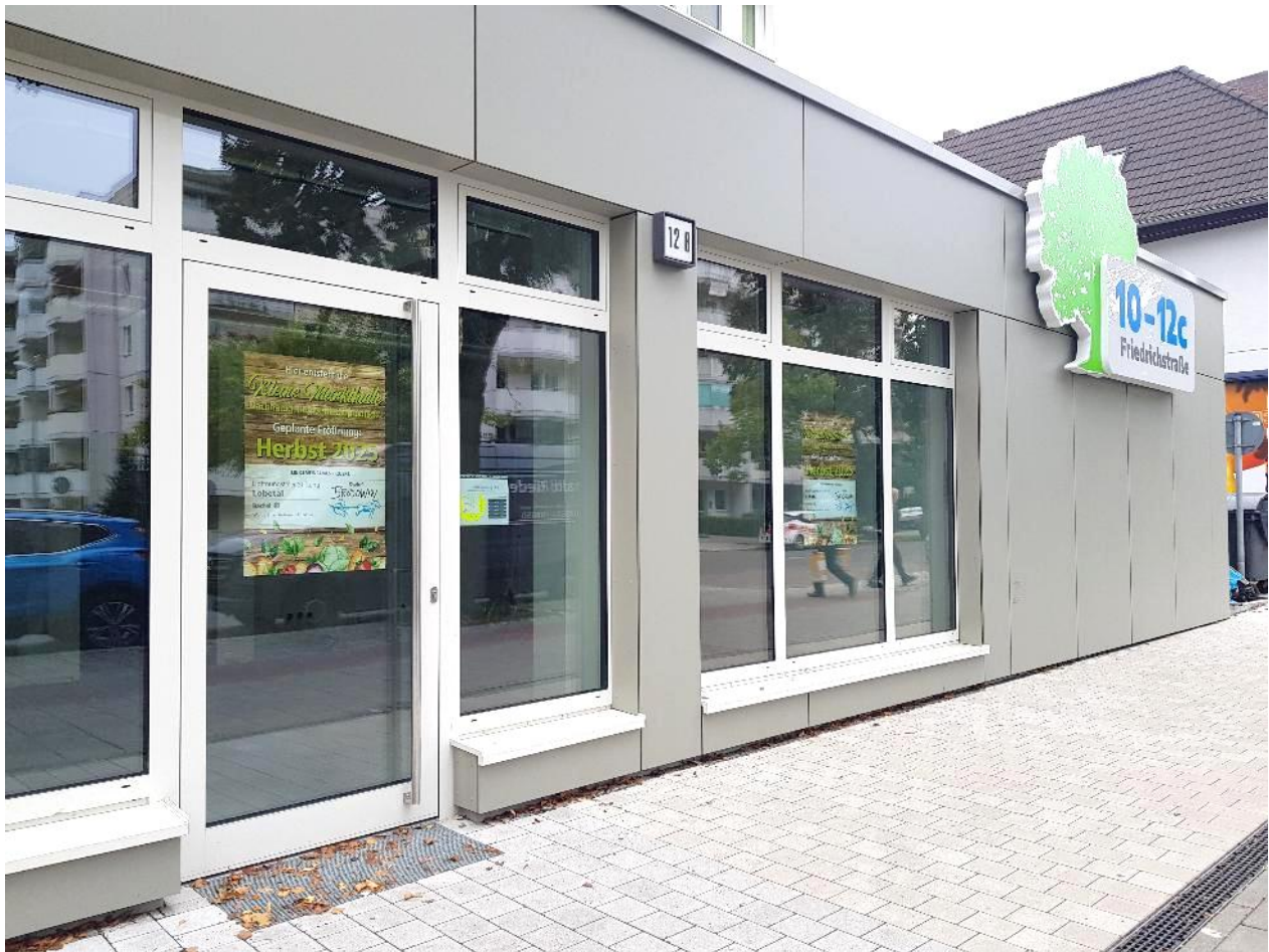
Abbildung 14 Neue Ladenflächen in der Friedrichstraße, September 2025
