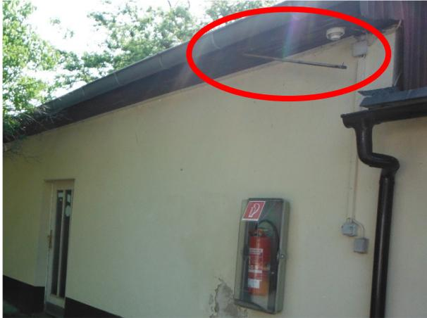
Abb. 21: Beschädigter Dachkasten am Werkstattgebäude
