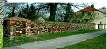
Mauer aus Raseneisenerz am Pffarramt Neuhardenberg
