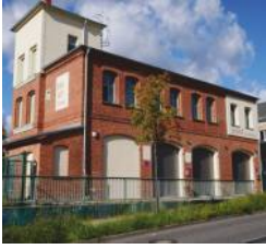
Alte Feuerwache (Bauhof) Rudolf-Breitscheid-Straße 29
