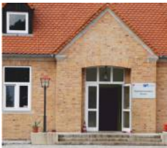
Bildungszentrum Erkner e. V. Seestraße 39 Telefon +49 3362 7690 Besichtigung des Turms nach Anfrage am Empfang
