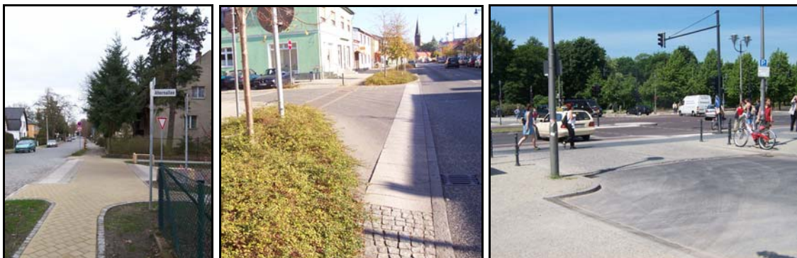
Abb. 24 Beispiele Gehwegüberfahrten bzw. -aufpflasterung (Erkner, Eberswalde, Berlin)
