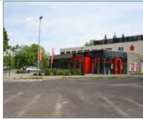
Abb.2) Sparkassenneubau am Flakenfließ
