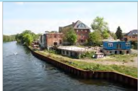
Abb.2) Grundstück und Gebäude der ehemaligen Bakelitfabrik, Rückansicht
